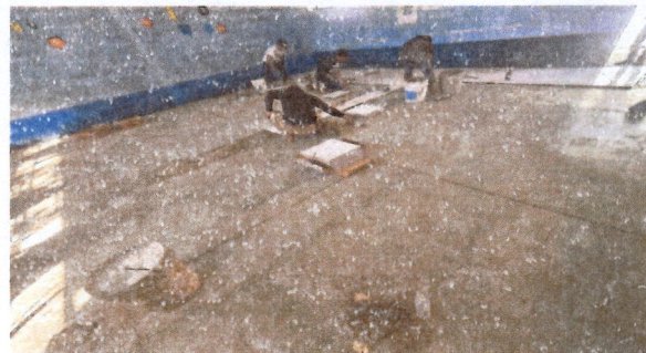
Foto 2: COLOCACION DE PISO CERAMISO EN EL AULA 1
